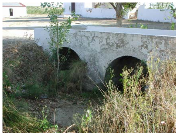
Fotografia II.14 – Ponte junto à ermida de Santa Luzia
